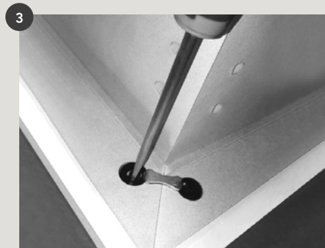
Skruva ihop foderbildande karmdel med medföljande sammansättningsbeslag, gör samma sak med lösa foder och ställ åt sidan.
